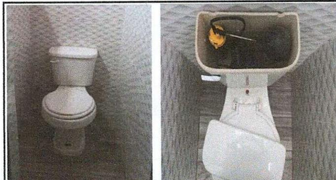
Foto 4: Culminación trabajos de sustitución de inodoros y accesorios.
