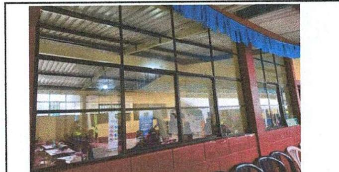
Foto 6: Culminación de cambio de ventanas fijas con plástico por ventanas corredizas con vidrio.
